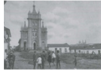
Construcción de Parque Colón, 1910
