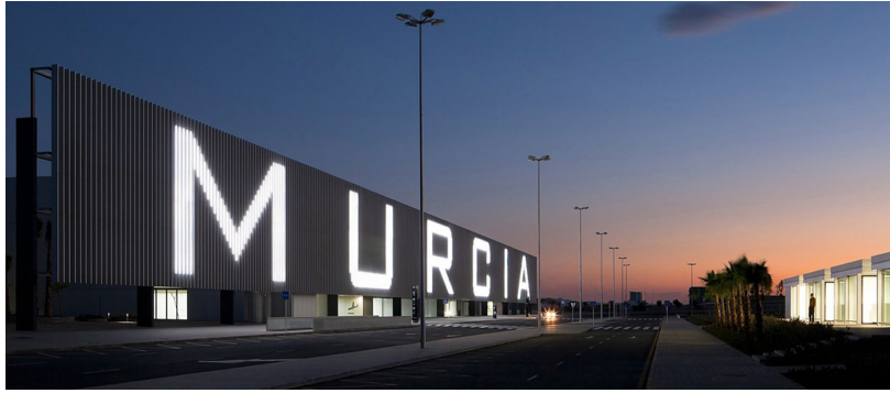
Figura 12. Vista de la fachada del aeropuerto de Murcia - Carlos Ferrater, Ramón Sanabria y Josep María Casadevall. Fuente: http://ferrater.com
